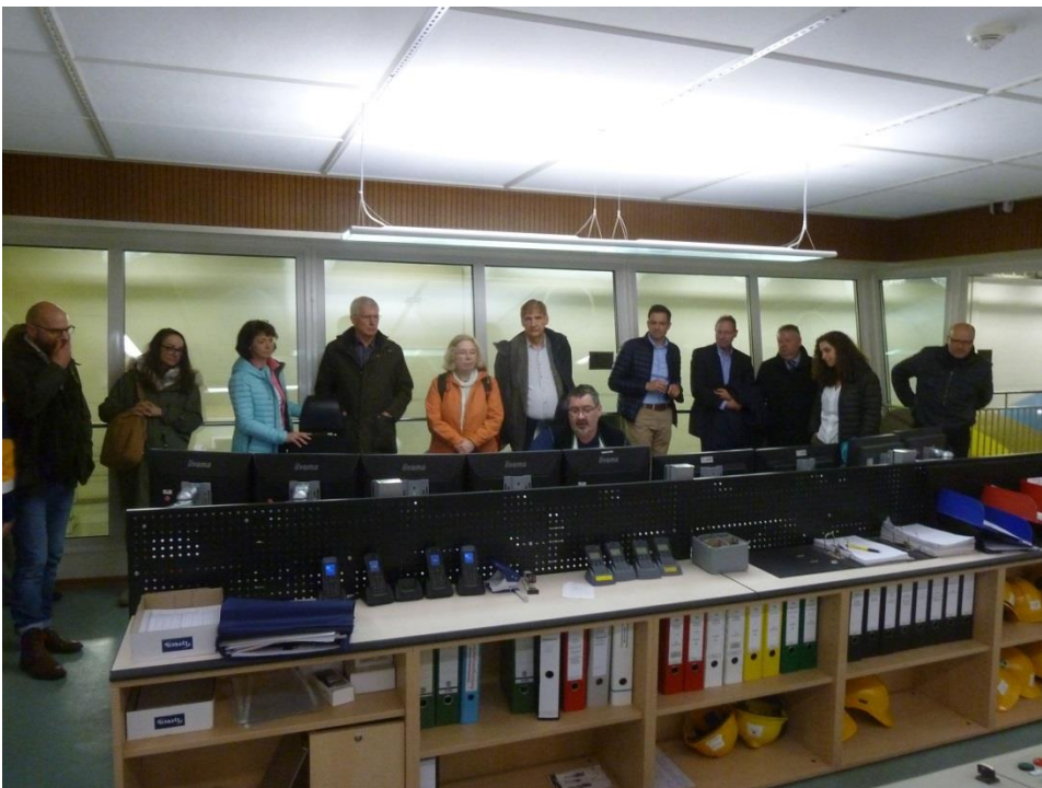
In der Leitwarte des PSW Geesthacht
